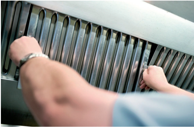
Abb. 9: Flammschutzfilter (Aerosolabscheider)
